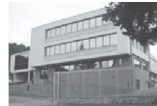
La sede della Kayser Italia in Via di Popogna.
